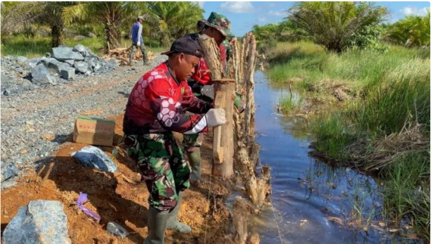
"Kayu Galam" Potensial Untuk Landasan Pemasangan Pondasi
